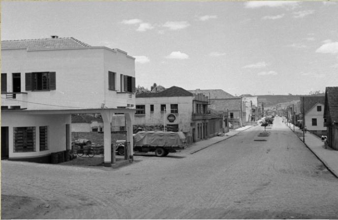
- Qv. Barão Rio Branco Caçador Sc / Posto Shell de Família Cury e Castelli, A obra que hoje desabou em Caçador foi neste local onde era o posto.
